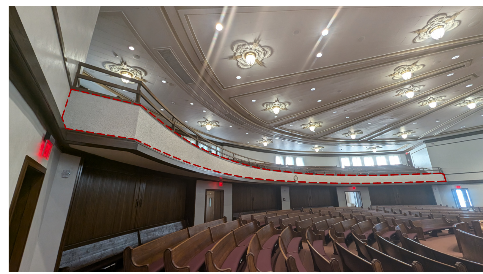
B3 ASBESTOS TEXTURE ABATEMENT
