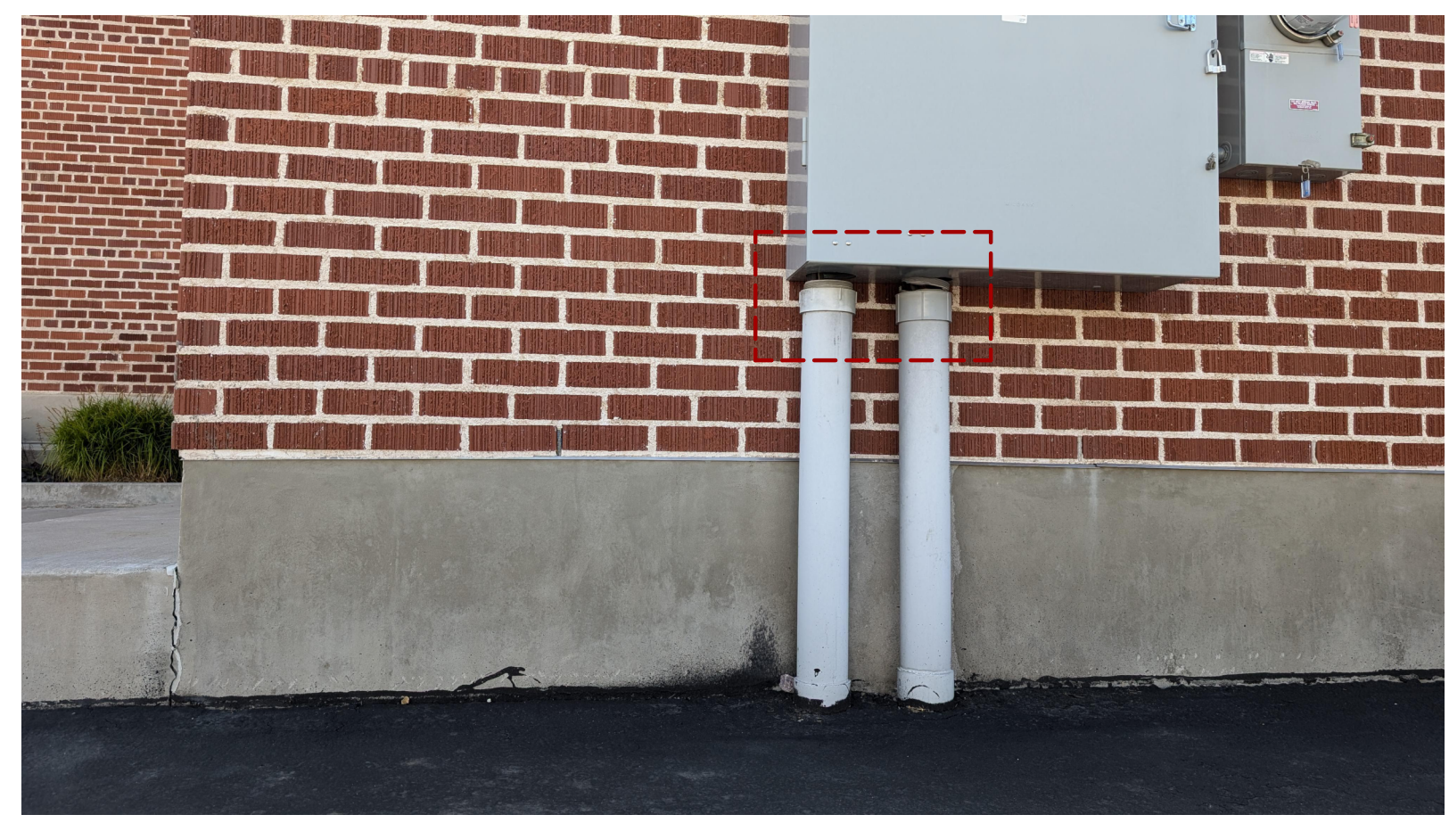
B1 ELEC CONDUIT SEPARATION
