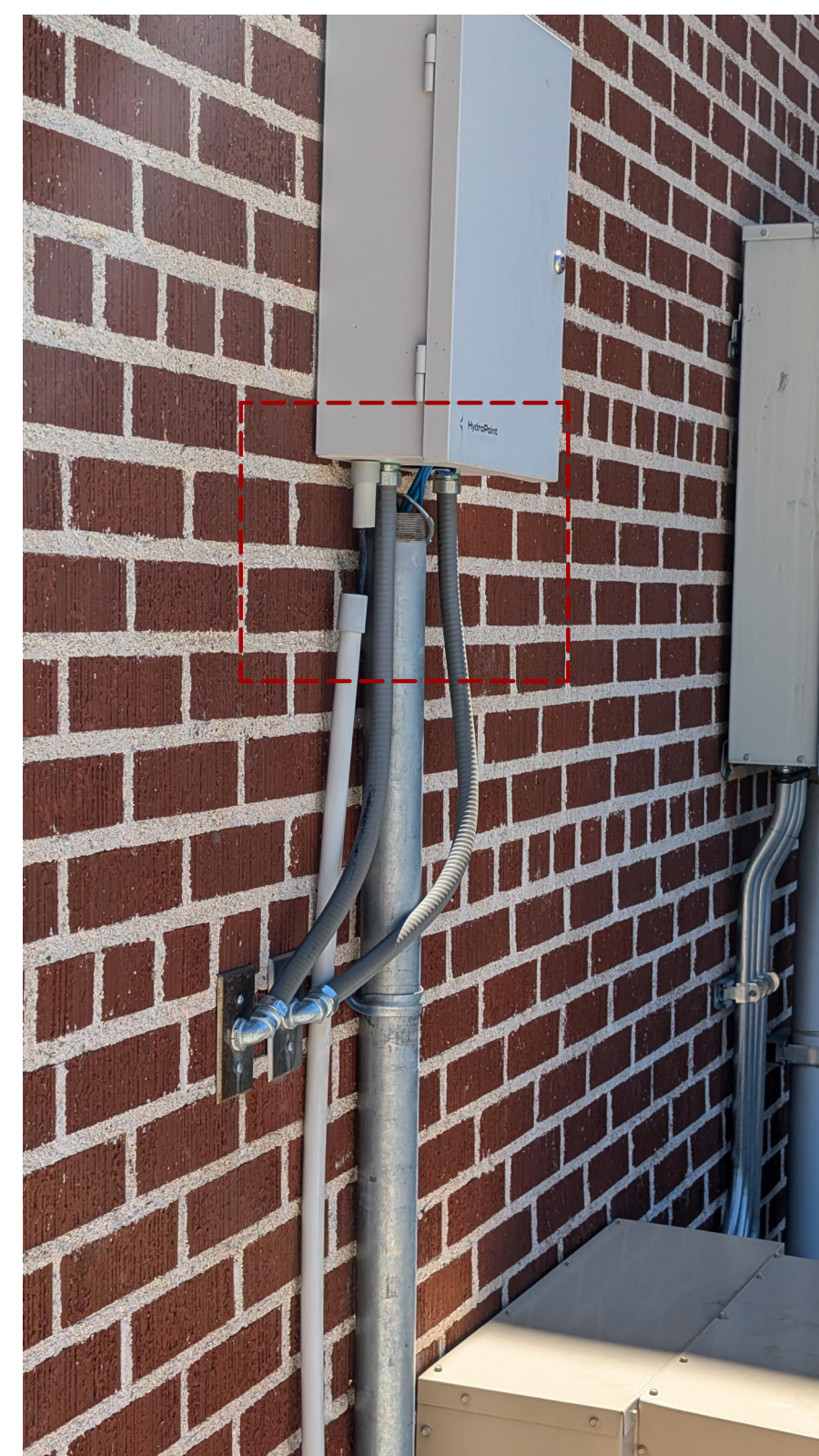
A3 SPRINKLER CONDUIT SEPARATION
